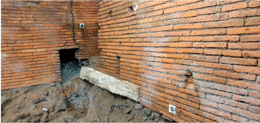
Muro con los ladrillos de la fase de Trajano./ Antonio Pizzo / EEHAR-CSIC
